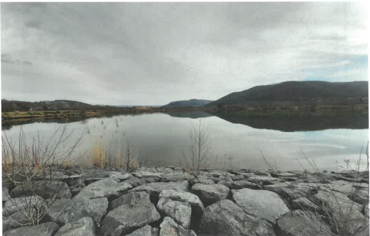
(Vue du Plan d'eau Amont depuis le seuil n° 4 séparant les deux plans d'eau)
