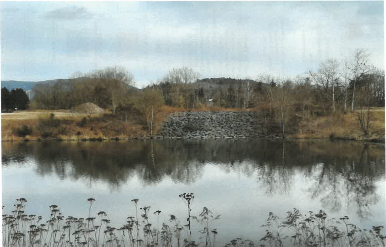
(Seuil n° 1 au Sud du Plan d'eau Amont)
