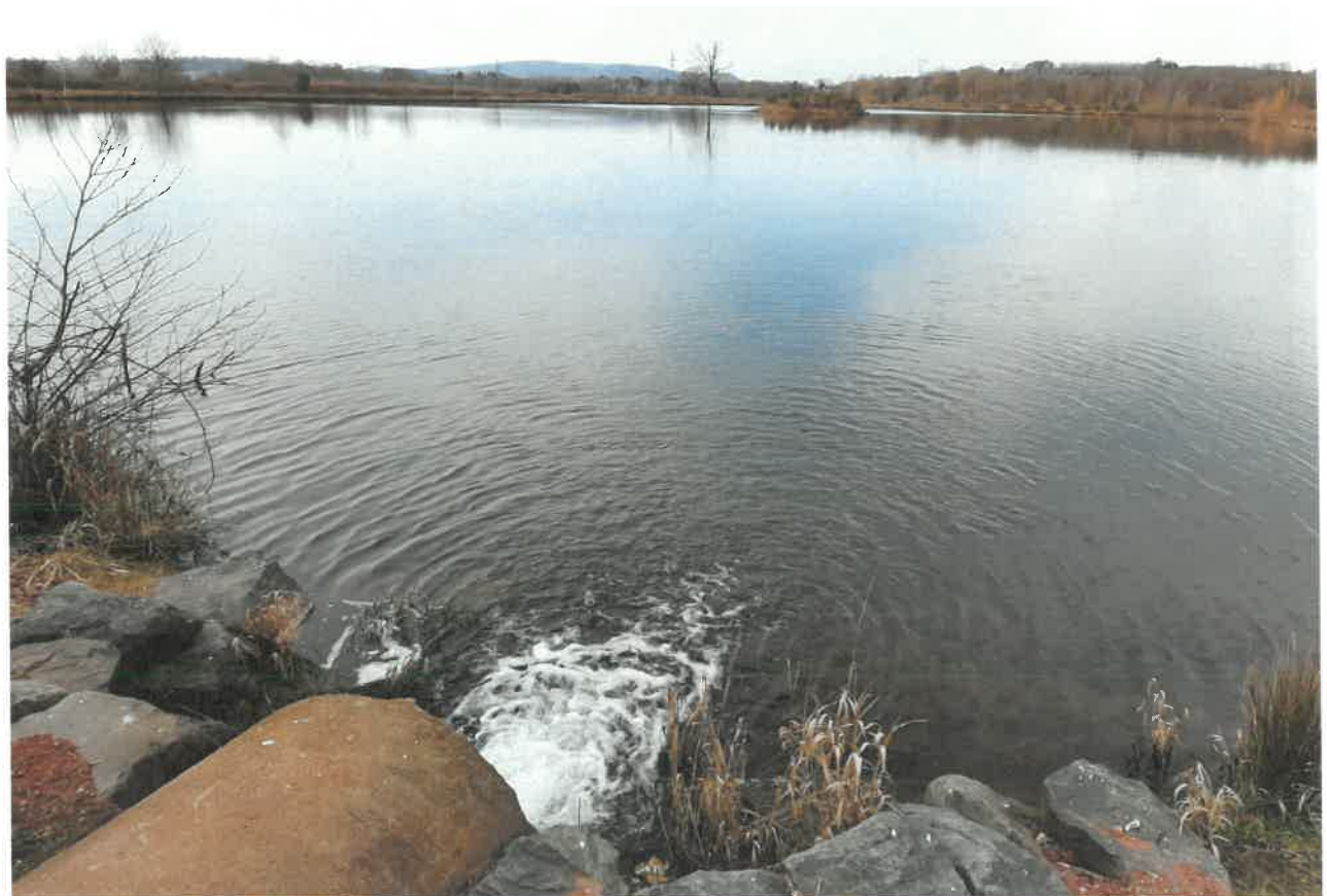
(Vue du Plan d'eau Aval depuis le seuil n° 4 séparant les deux plans d'eau avec tuyau de communication et îlot)
