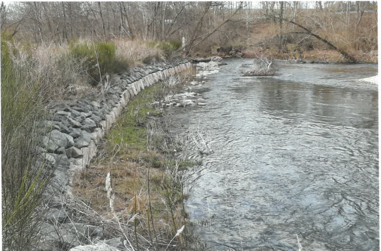
(Renforcement des berges de la Meurthe située à l'Est des Plans d'eau)
