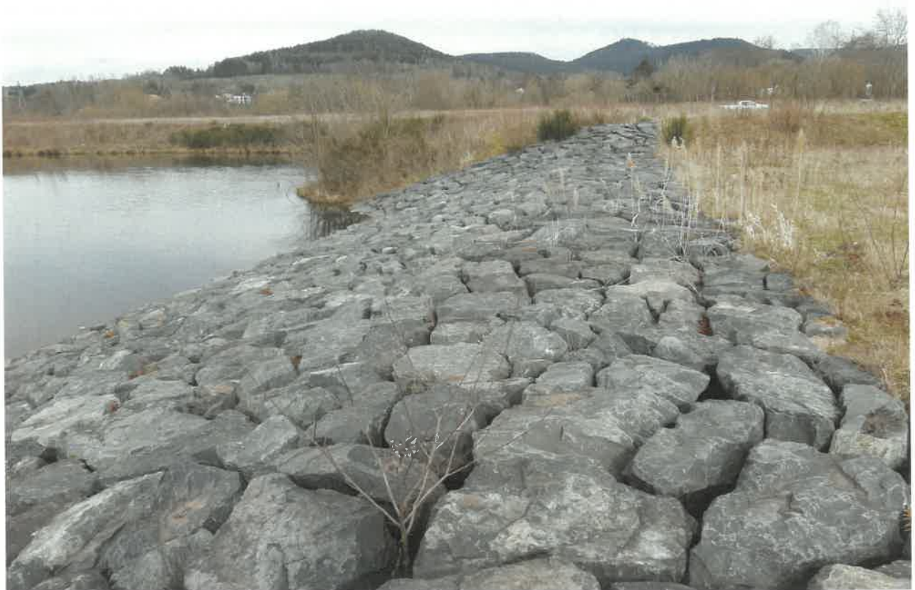
(Seuil n° 4 séparant les deux plans d'eau)
